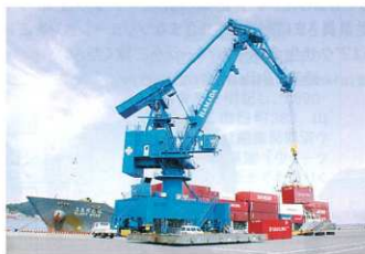
設置された大型クレーン
