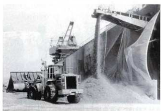
輸入されたウッドチップの積み降ろし作業
