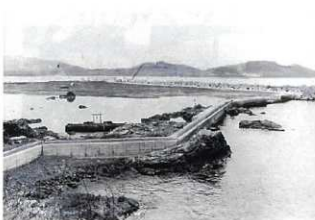
平成11年の完成を目指し福井地区で進む埋め立て工事
